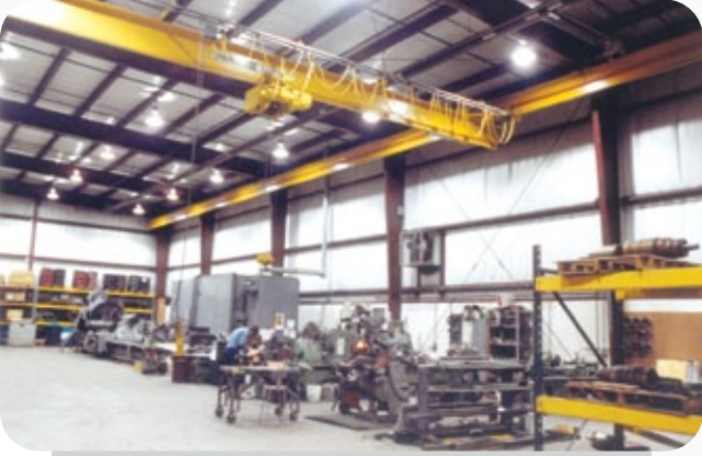
Fabrika Uygulaması: Seri Yakıclı Sistem - Genel Isıtma
